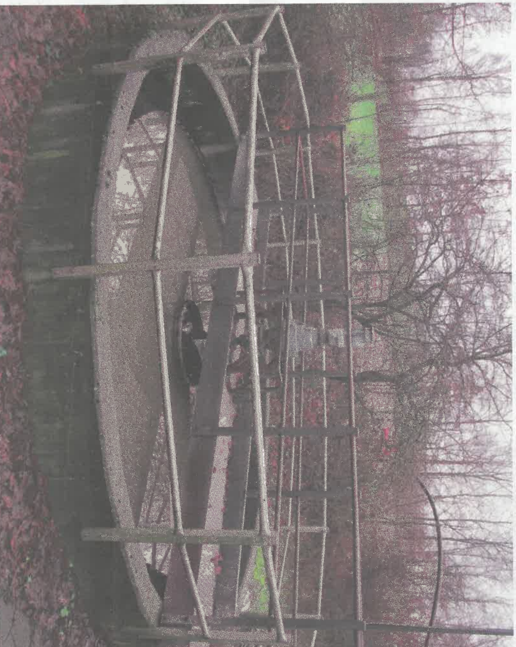
Figur 1: Eksempel på bundfældningstank fra mindre rensningsanlæg. Løsninger til bundfældning af husdyrgødning skal være over-dækkede. Foto: Niels Østergaard
